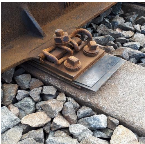
Kuva 8. Nippu kiiloja aluslevyn ja ratapöllin välissä (Haukivuori V801)
