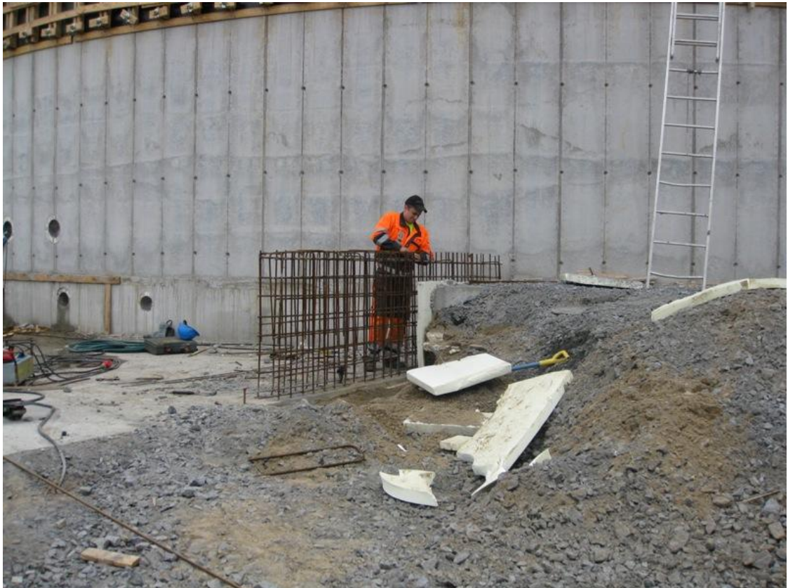
KUVIO 7. Kirjoittaja tarkastamassa siipimuurin raudoitusta.
