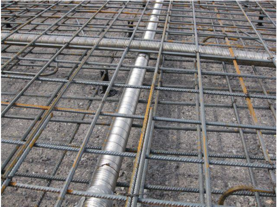
KUVIO 5. Raudoitukseen kiinnitettävät jännitysvaijerien putket.
