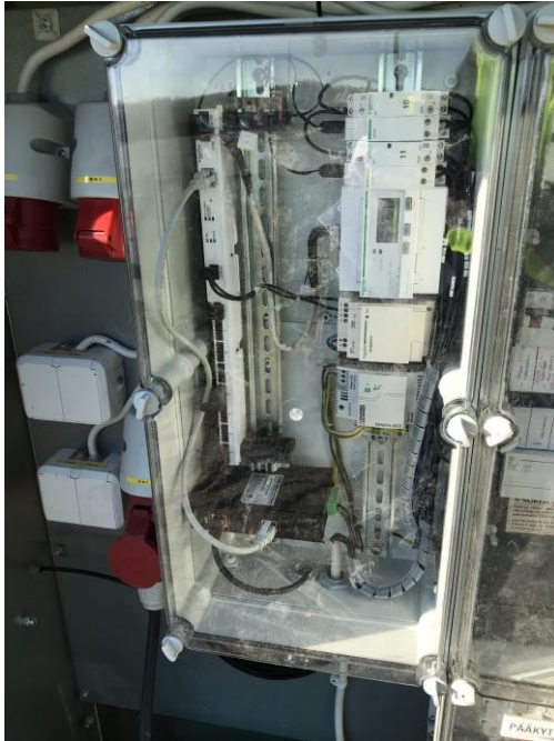
Kuva 13. Ohjauskomponenttien asennus lisäkoteloon.
