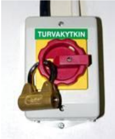
Kuva1 Lukittu turvakytin
