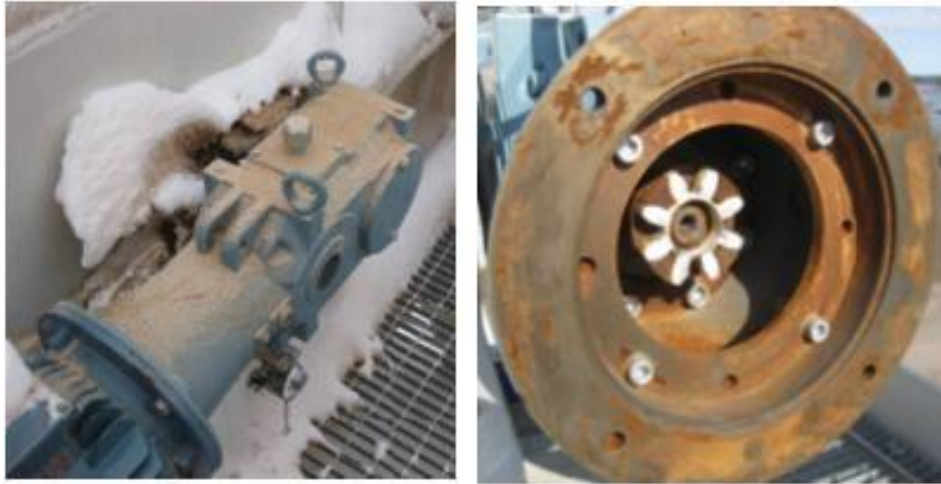
Kuva 3.18. Vaihdemoottori
