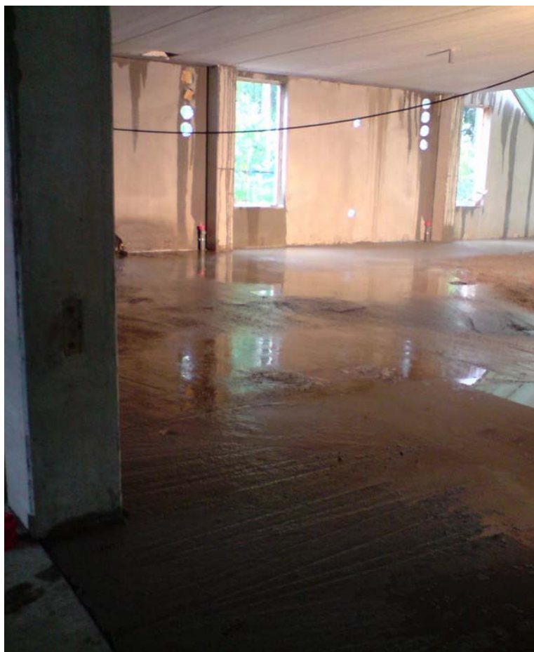
Kuvio 10: Esimerkkikohteen lattioiden valua huonoissa olosuhteissa.
