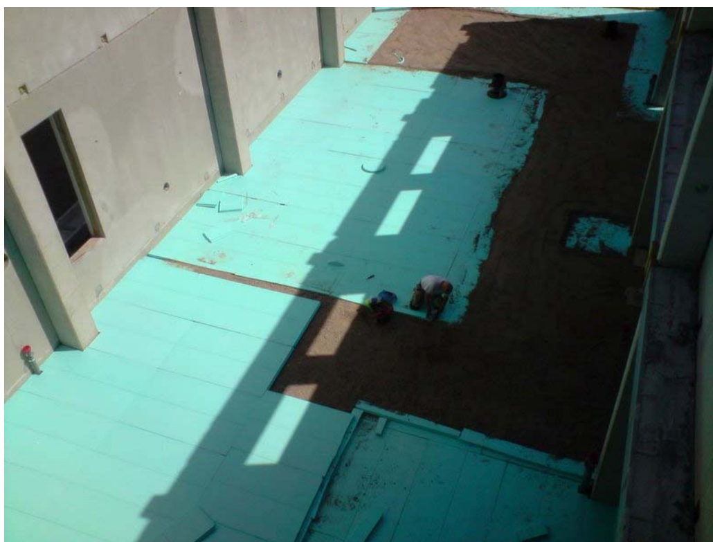
Kuvio 9: Eristeiden asennusta ja pohjan tasausta
