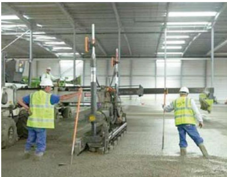
Kuvio 4: laserohjattu levityskone (Matsinen 2008b)
