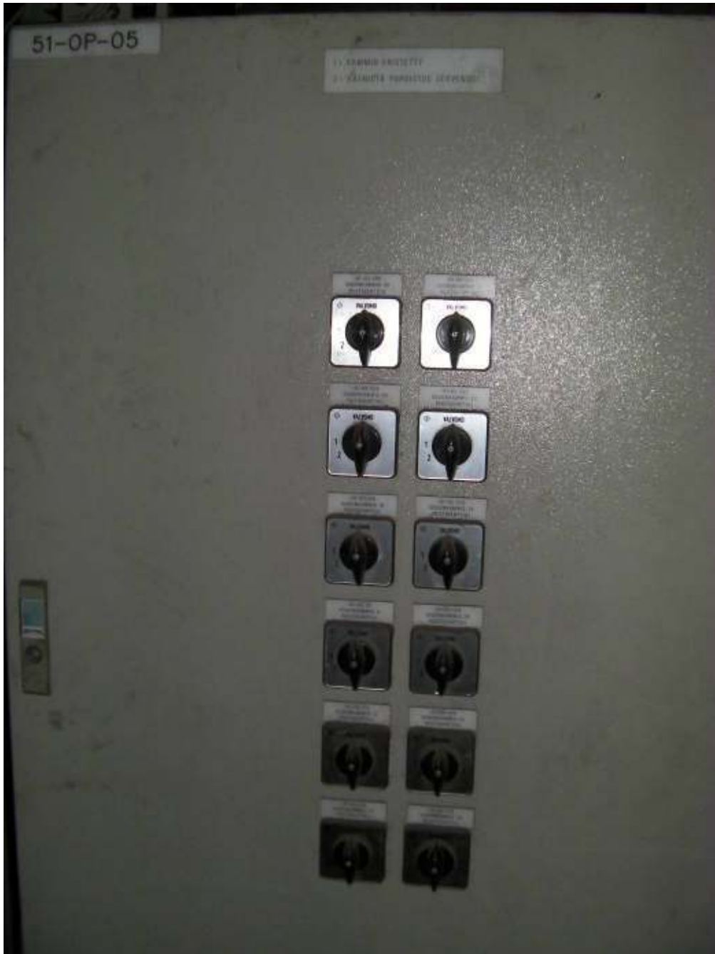
Kuva 6. Suodatinkammioiden käyttökytkimet. Käytetään kytkintä asennossa ”2”, jotta järjestelmästä tyhjenee paineilma. Pölypussin puhdistusjärjestelmä pitää kovaa ääntä, joten paineilman tyhjennyksen jälkeen ei ole kuulovaurion vaaraa.
