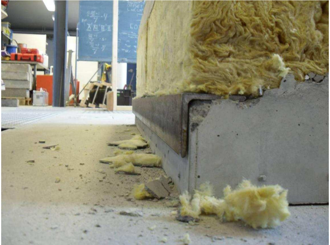
Kuva 6.13 Kulmateräksen asennus sisäkuoreen
