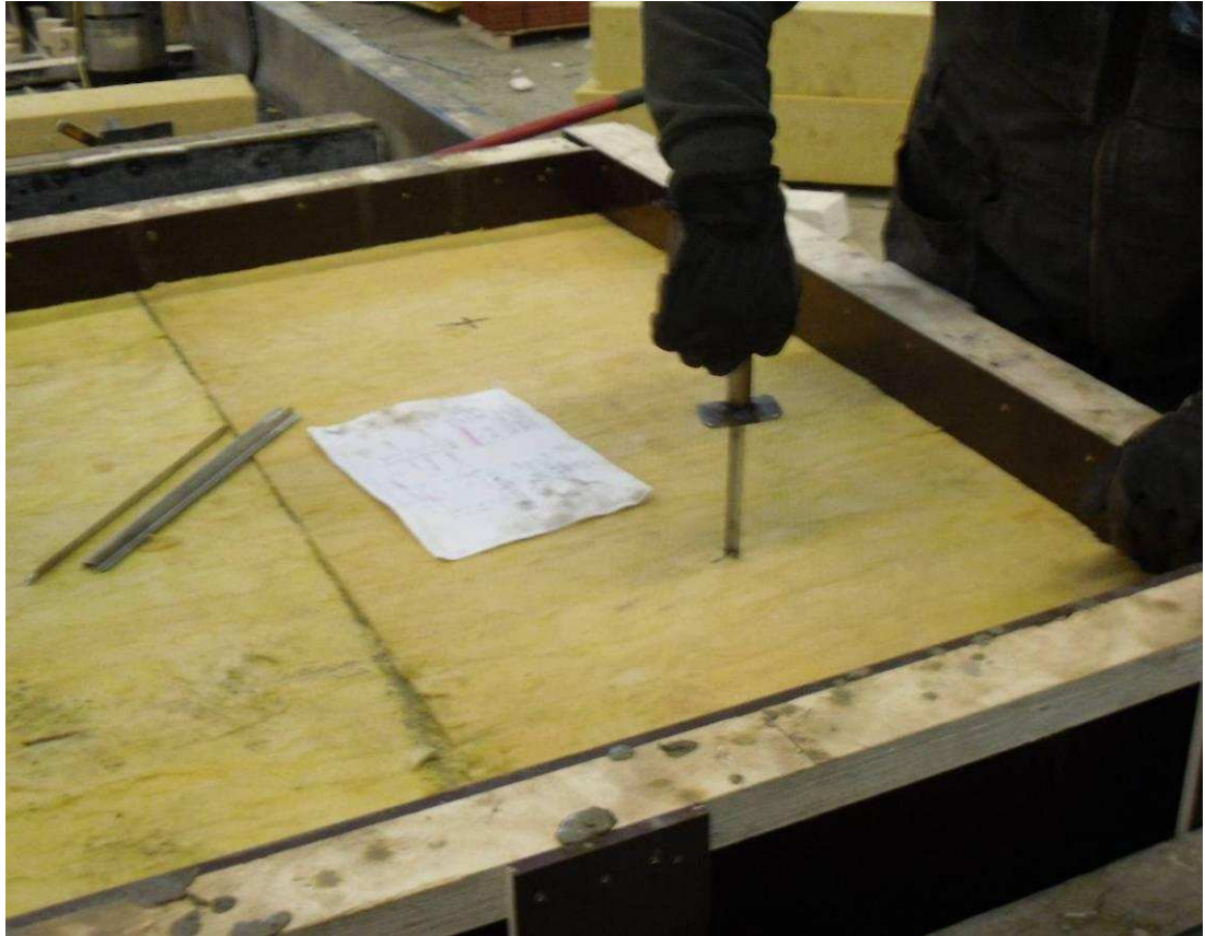
Kuva 6.9. Taiter-pistoansaiden asennus eristekerroksen läpi
