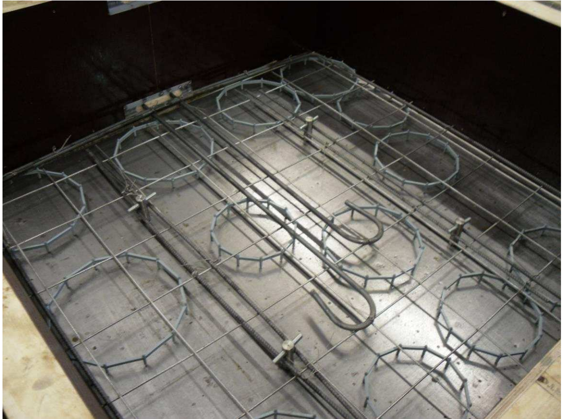
Kuva 6.8. Testielementin ulkokuoren raudoitus
