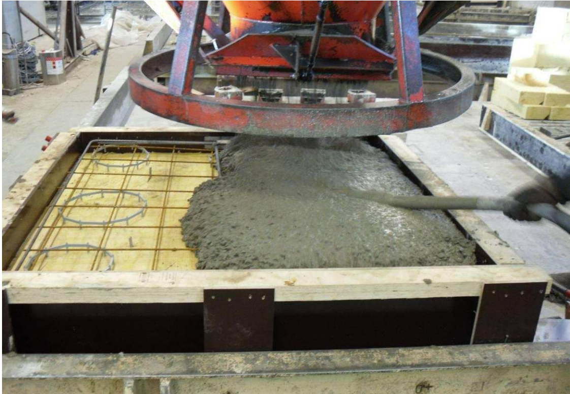
Kuva 6.11. Testielementin sisäkuoren betonointi ja vibraus
