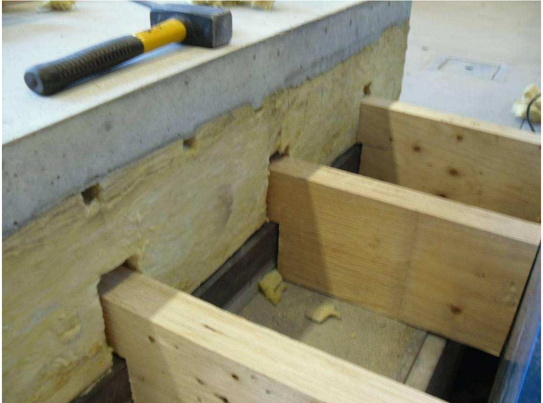
Kuva 6.15. Kertopuupalkkien asennus kulmaterästä vasten
