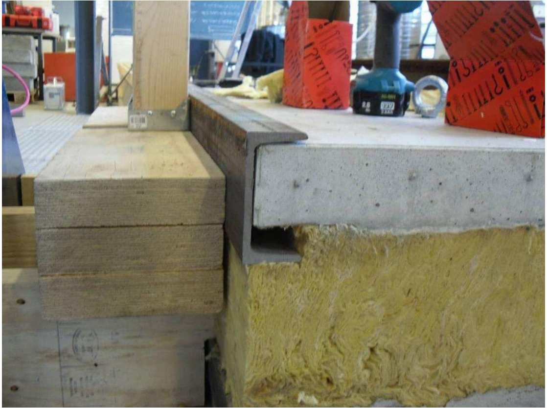
Kuva 6.17. Asennettu U-palkki
