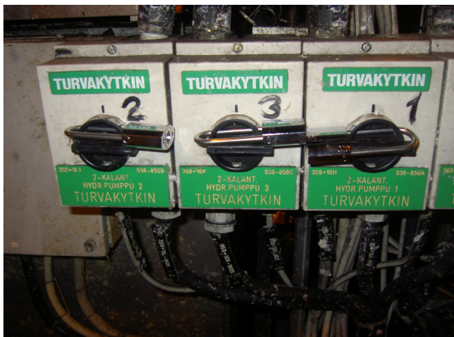
Kuva 21. Kalanterin hydraulipumppujen turvalukitus
