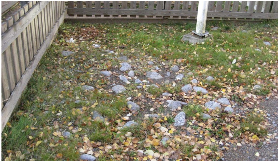
Kuva 5 Kenttäkiveys on saumattu kivituhkalla. Alueelle on kasattu lunta talvisin ja kiviä on irronnut. Saumojen väliin on kulkeutunut humusta ja nurmiheinät ovat vallanneet kiveyksen.
