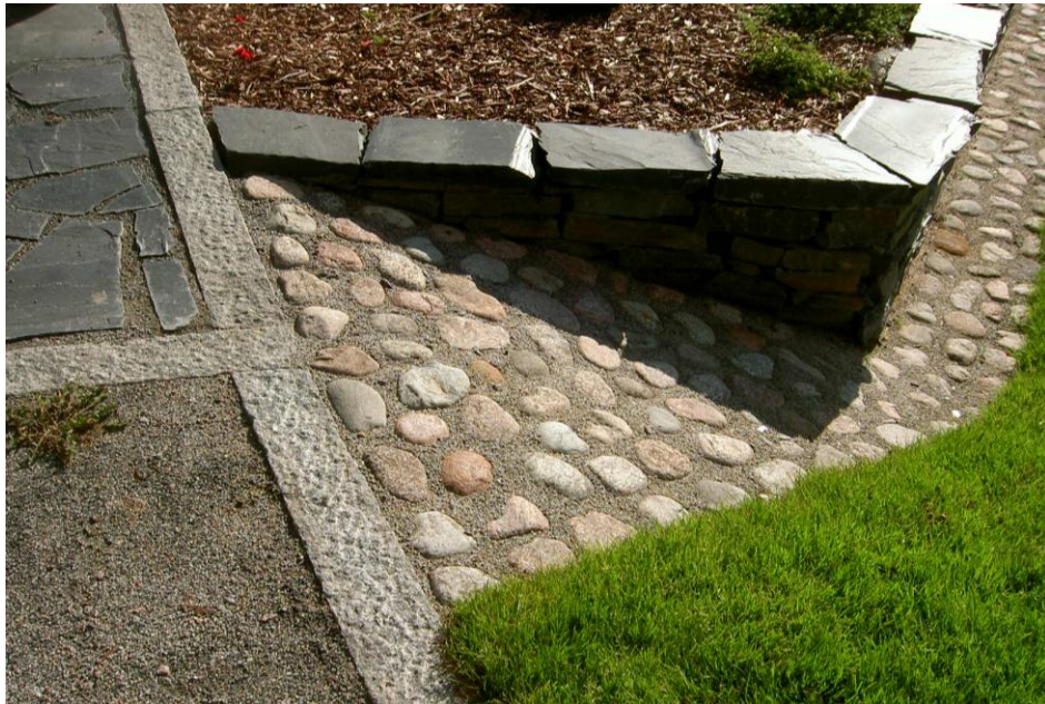
Kuva 30 Siististi saumatut kiveykset eivät kasva rikkaruohoja toisin kuin kivituhka käytävä.
