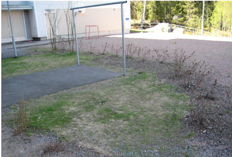
Kuva 19 Rajaamaton ja epäselvä istutusalue. Hiekka, kuorikate ja multa ovat sekoittuneet, nurmikon kasvualusta tiivistynyt ja pensaat ovat kärsineet lumenkasauksesta.
