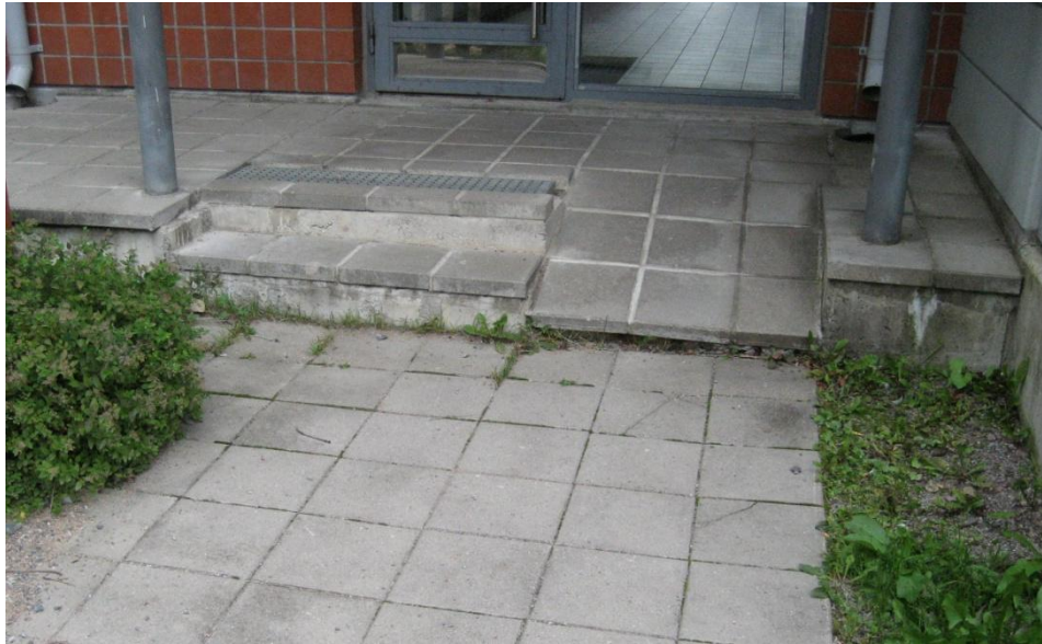
Kuva 11 Luiskaa on vaikea käyttää, se on lyhyt ja kynnyks vaikeuttaa nousemista. Kivituokkapinta on ruohottunut pahoin ja ilme epäsiisti.
