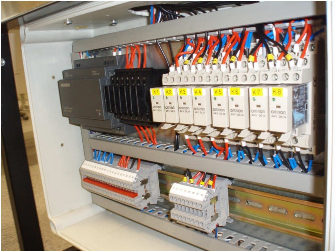
KUVIO 8. Vasemmalta oikealle: LOGO!Power-virtalähde 5A, sulakkeet ja Omronin valmistamat releet
