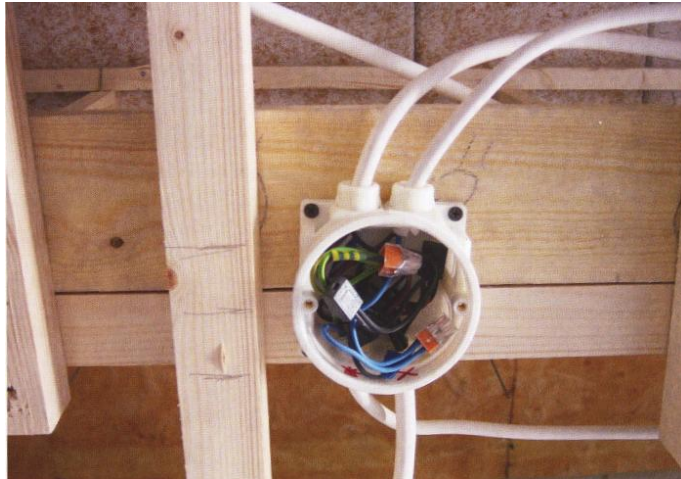
Kuva 11. Suojaus eristämällä jännitteiset osat [4, s. 78]
