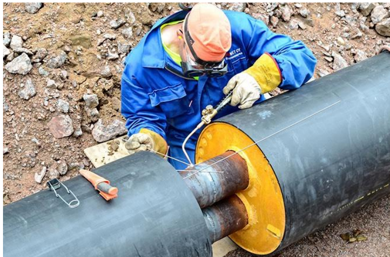
KUVA 1. Warmnet Oy:n työntekijä asentamassa kaukolämpöputkea (Karvinen 2019-04-23)
