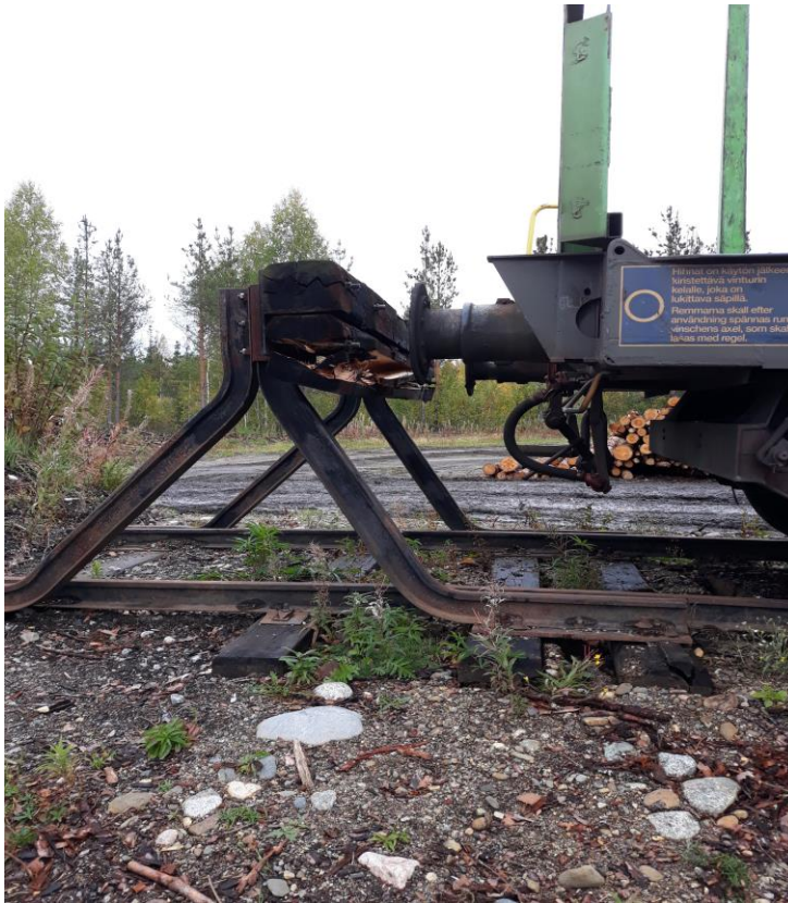
Kuva 2. Törmäyksestä rikkoontunut päätepuskin. (Kuva: Janne Lappalainen)
