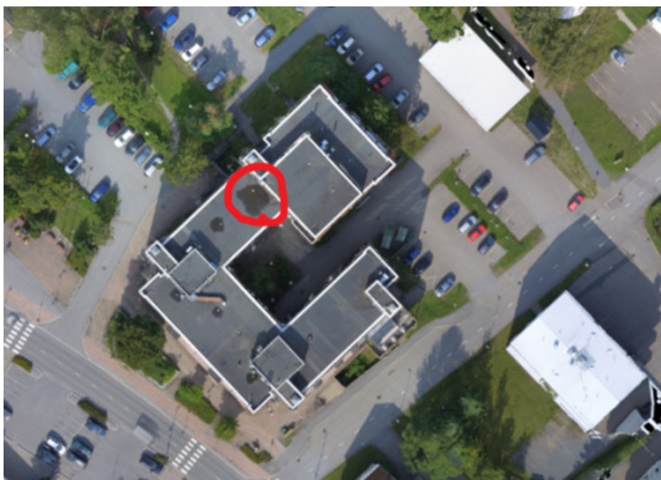
KUVA 2. Esimerkki katon kuvauksesta (kuva Esa Hannus)
