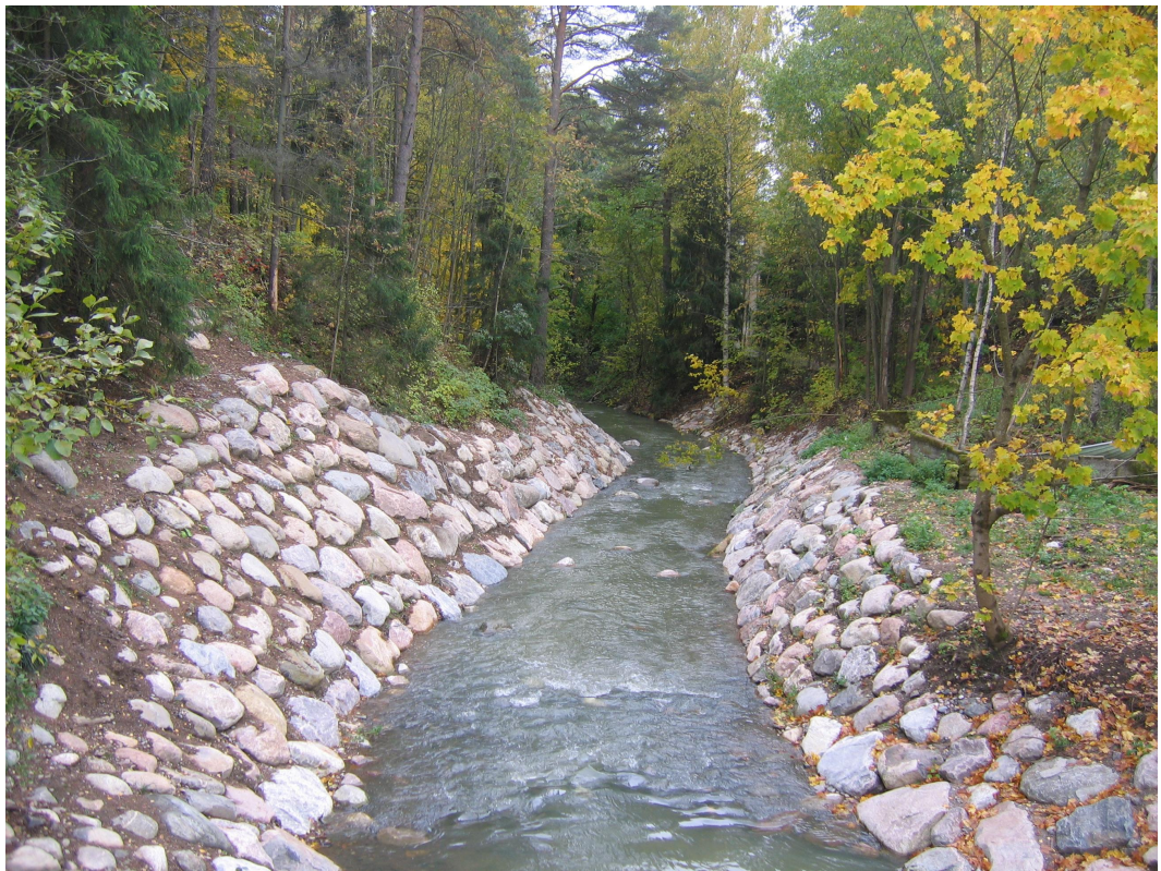
KUVIO 7. Monotonisesti kunnostettu virtapaikka ja eroosiosuojausta pyöreällä kiviaineksella.
