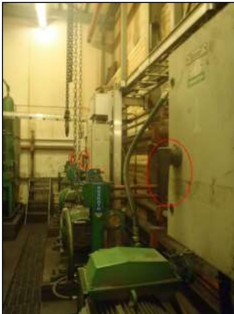
Kuva 3. Korkeapainepumppujen turvakytkimet.
