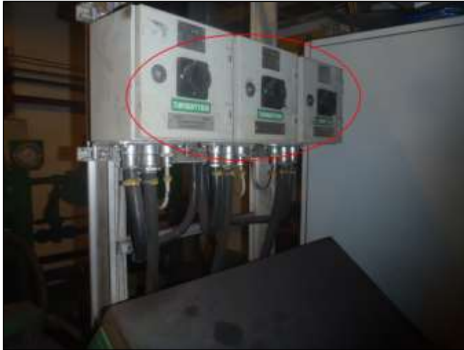
Kuva 2. Matalapainepumppujen turvakytkimet
