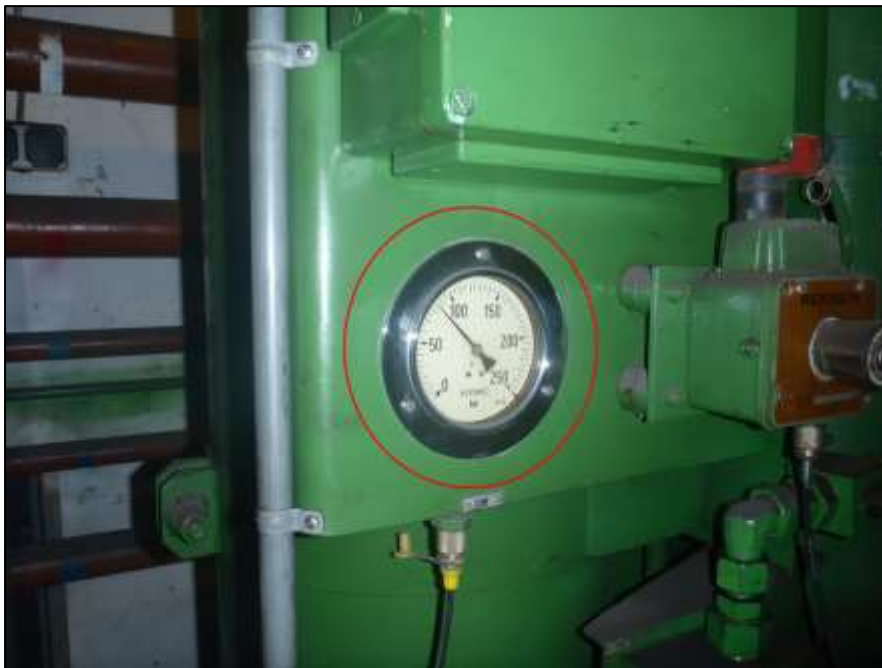
Kuva 7. Matalapainejärjestelmän painemittaristo.
