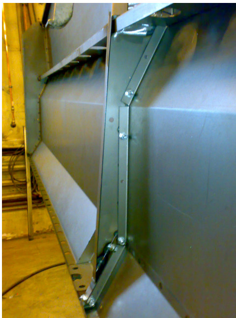
Kuva 16. Suojan keskiliitos esikokoonpantuna
