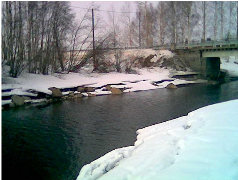
KUVIO 11. Mustijoki keväällä 2005. Perkauksen jäljet näkyvät rannalla kivien muodostamana helminauhana. Kuva: Juha Piilola
