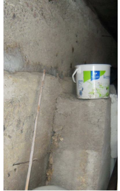
Kuva 3: Vanhan puolen sokkelin vahvistus
