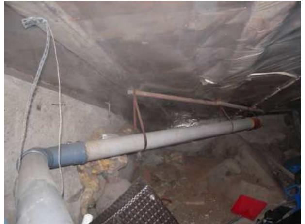
Kuva 9: Alapohjan viemäri- ja sähköputket
