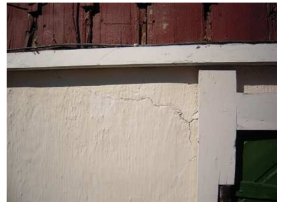
Kuva 4: Vanha sokkeli ulkopuolelta
