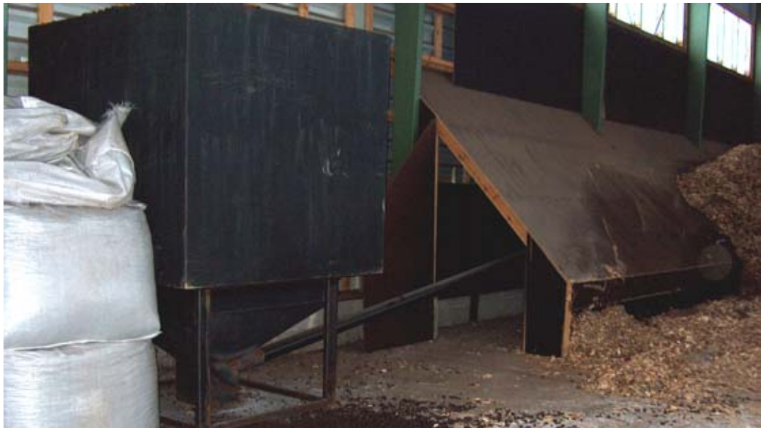
KUVIO 4. Turvellettsiilo hakevarastossa
