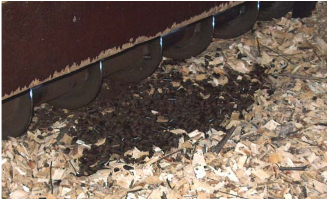
KUVIO 3. Turvepelletin sekoitusmenetelmä Kyyjärven lämpölaitoksessa
