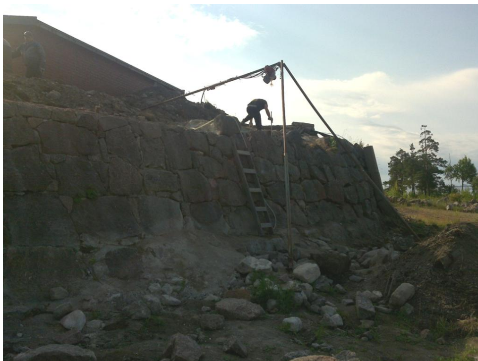
Kuva 9. Kolmijalkanosturia käytetään kivien nostoon Kotkan Katariinassa
