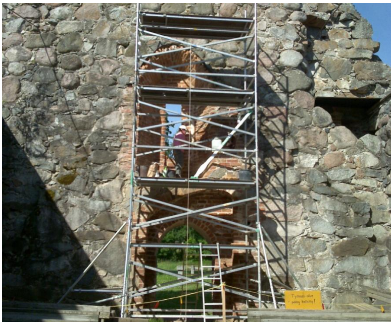
Kuva 12. Kuuden metrin korkeiset rakennustelineet Pälkäneen rauniokirkolla
