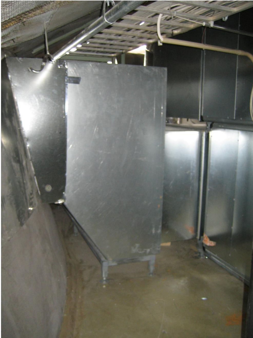
Kuva 15. Ilmanvaihtokoneen 392 TK/PK raitisilmakammio.
