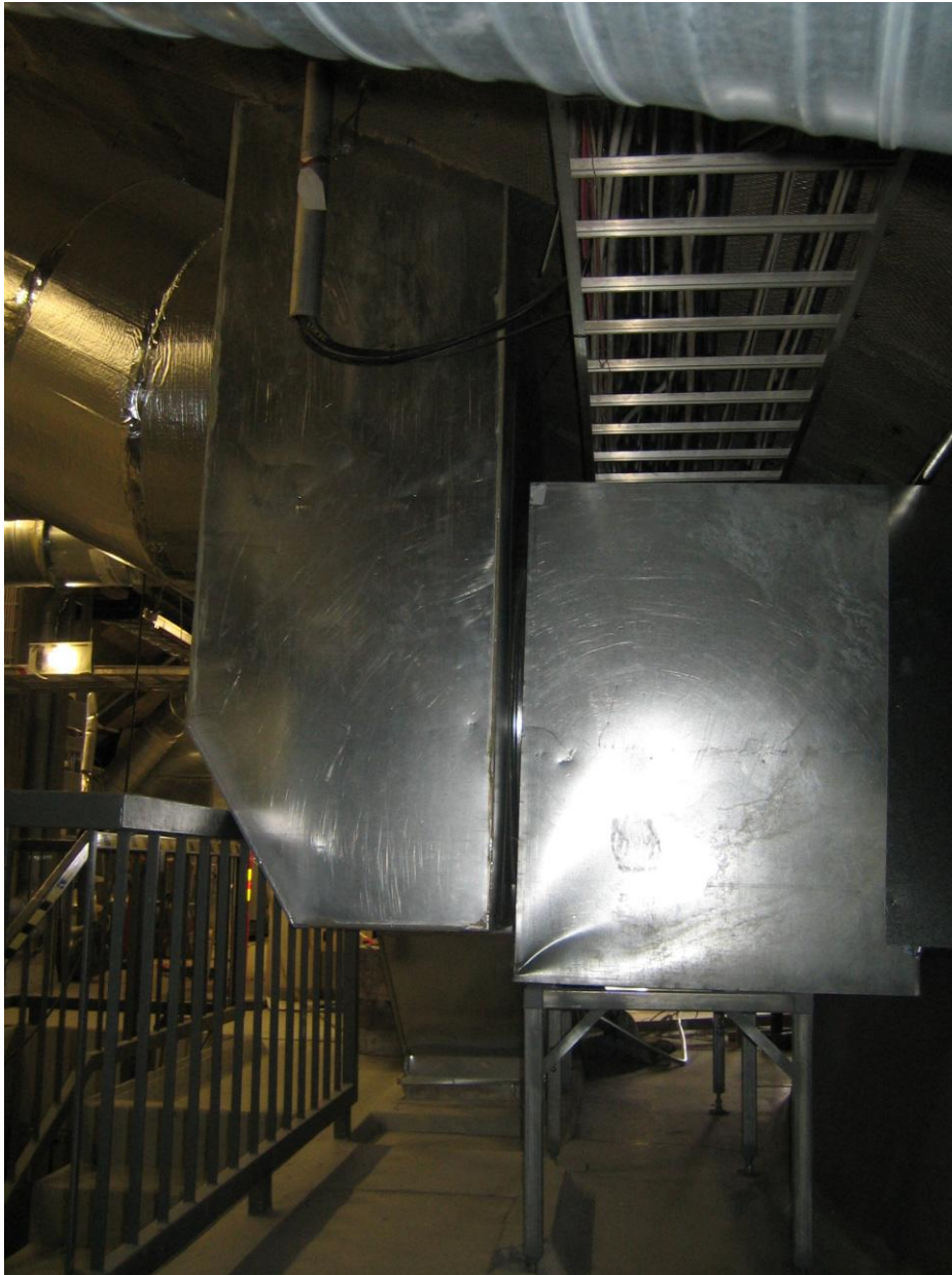
Kuva 17. Ilmanvaihtokoneen 394 TK/PK raitisilmakammio.
