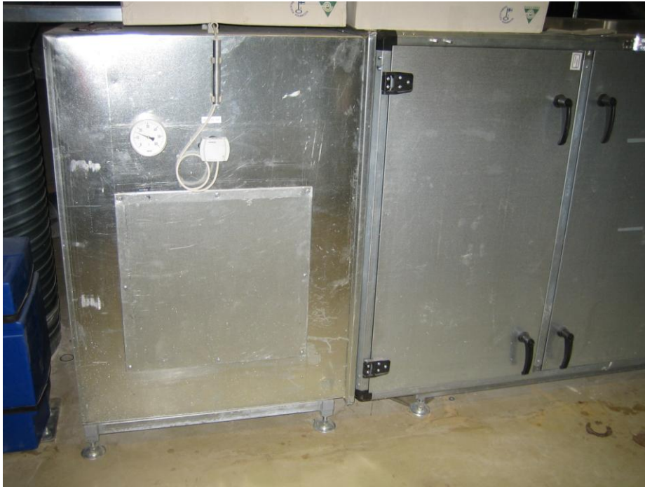
Kuva 19. Tuloilmakammio 392 TK/PK, kanava kytketty kammion alapuolelle.
