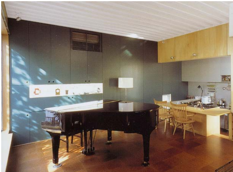
Kuva 7. Seinän sisään piilotettu kaapisto. (Schleifer 112-113)
