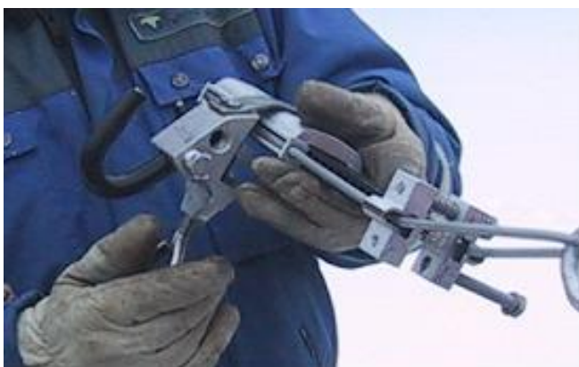
Kuva 7. Päätepitimen asennus erikoistyökaluun./12/
