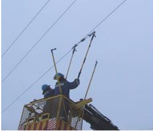
Kuva 4. Jännitetyönä tehtävä erotus./12/
