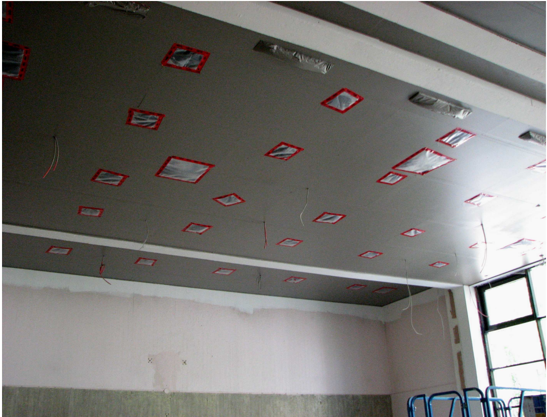
Kuvio 8. P1-tilan läpiviennit on tulpattu muovin ja teipin avulla.
