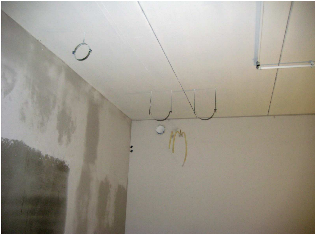
Kuvio 9. Ilmastointiputkien kiinnityslenkit on kiinnitetty kattoon ennen P1-luokitusta.
