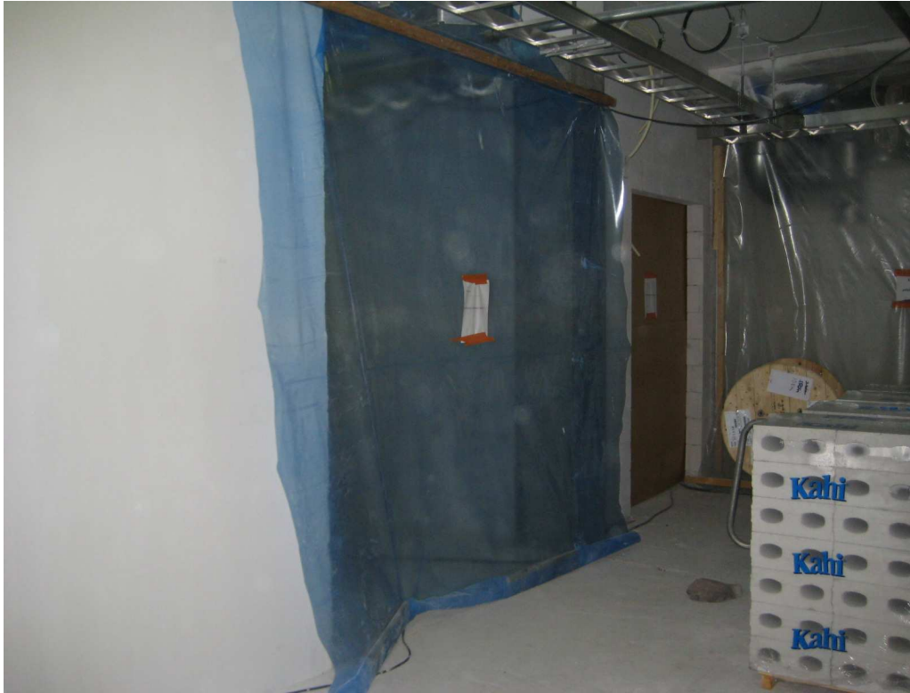
Kuvio 1. Oviaukot on eristetty lautojen ja muovien avulla.
