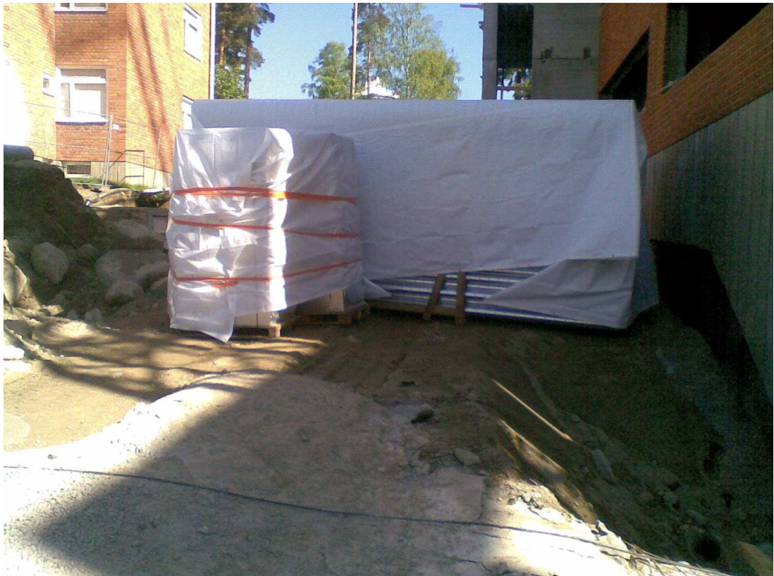
Kuvio 3. Ulos varastoidut rakennustarvikkeet suojattiin sateelta ja varastoitii irti maasta.
