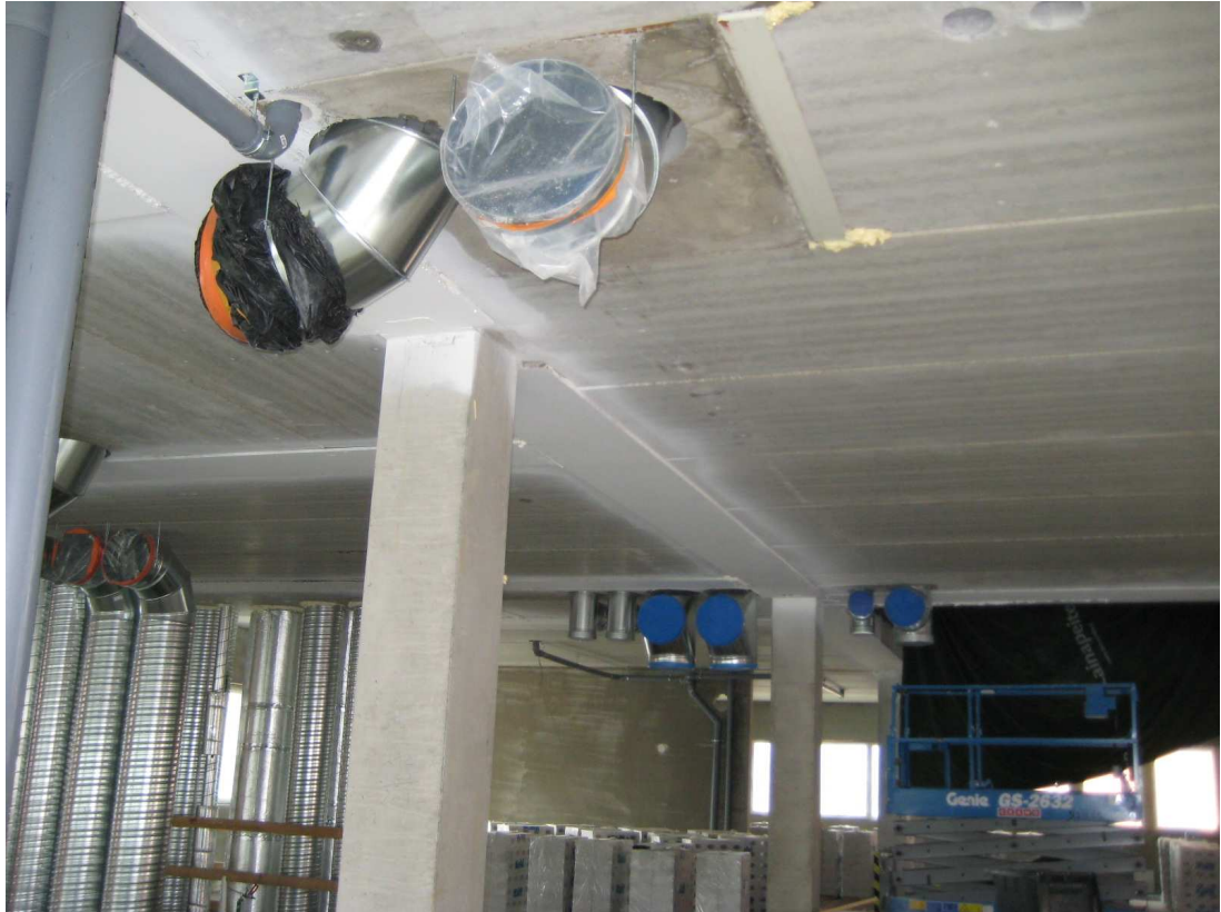
Kuvio 4. Ilmastointi putket tulpattiin muovilla ja teipillä P1-luokkaa varten.
