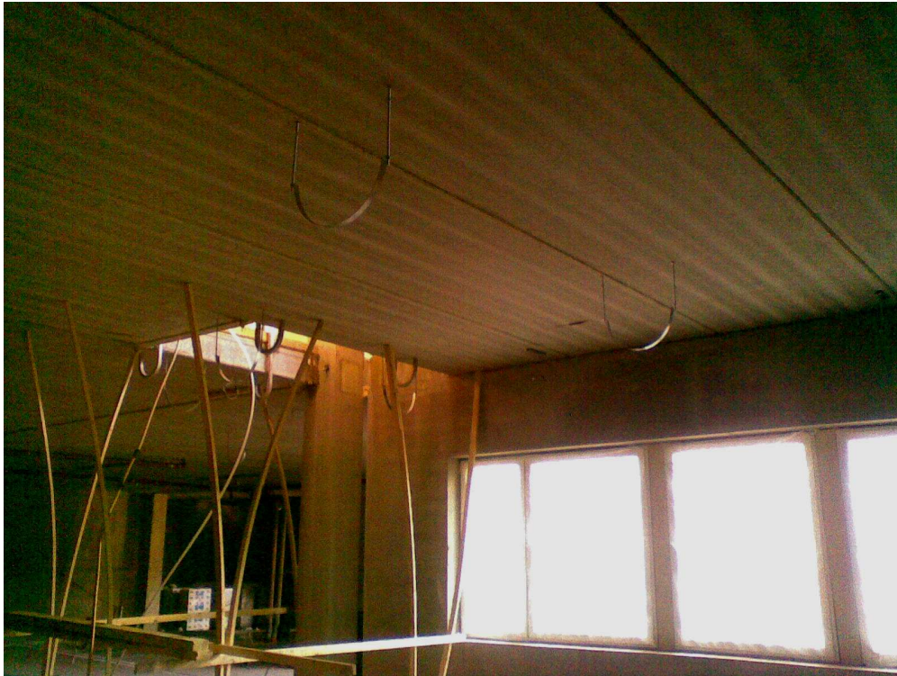
Kuvio 5. IV-laitteiden kiinnityslenkit porattiin kattoon kiinni ennen P1-vaihetta.
