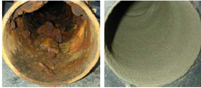
Kuva 20: Sementtilaastivuoraamalla saneerattu vesijohto. [27.]
