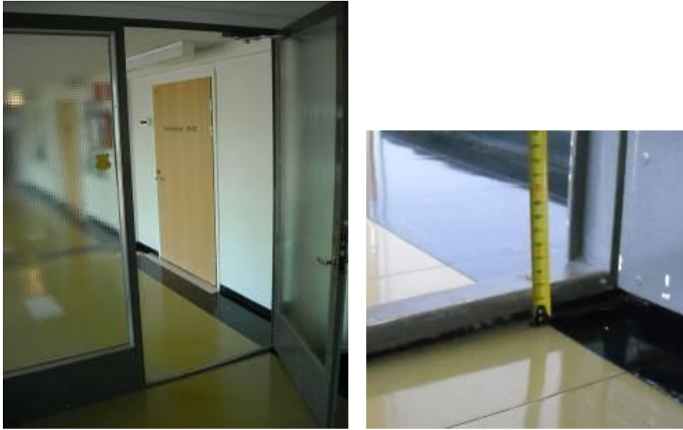
KUVA 33. Aulan puoleinen R-osan käytävän palo-ovi ja kynnys
