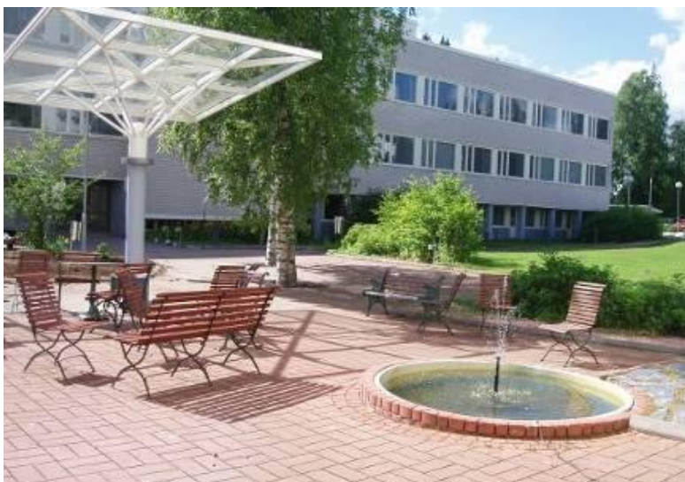
KUVA 14. Kuntokatu 4:n takana sijaitseva sisäpiha
