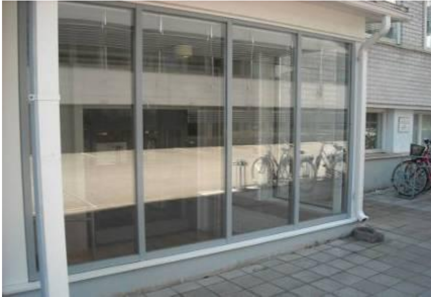
KUVA 10. Invasisäänkäynnin viereiset ikkunat voivat aiheuttaa törmäysvaaran
