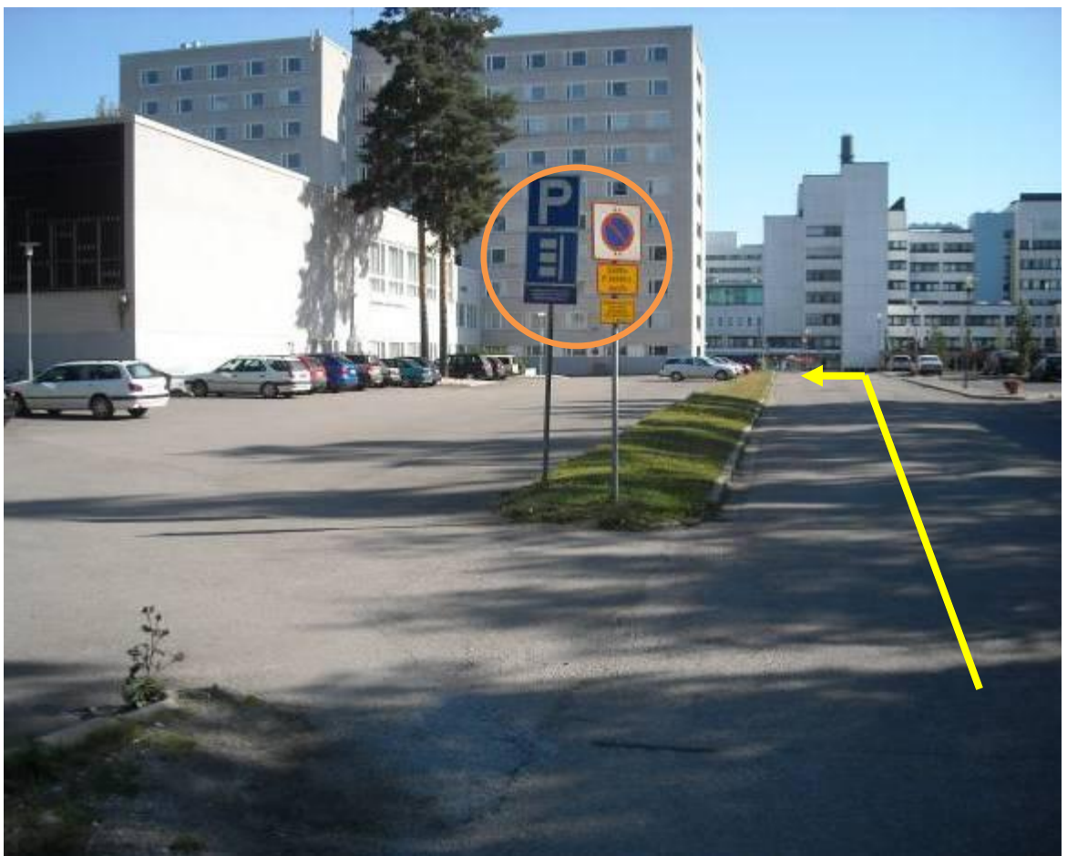
KUVA 5. Liikuntaesteiselle soveltuva sisäänkäynti sijaitsee rakennuksen takana, joten oppilaitokseen saapuvan on osattava suunnistautua kuvan nuolen osoittamaan suuntaan ilman opasteita
