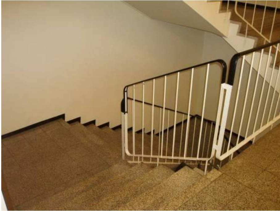
KUVA 20. Tornirakennuksen, eli S-osan portaikko
