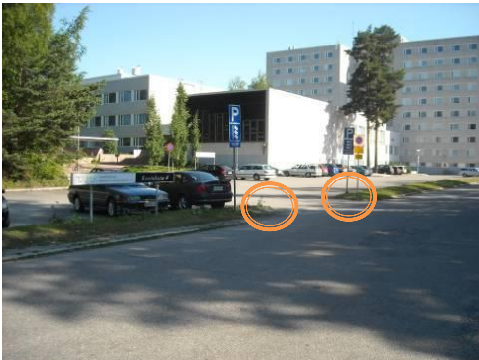
KUVA 4 Pysäköintipaikkojen huonot rajaukset aiheuttavat autojen väärin-pysäköintiä liian lähelle pysäköintialueen sisäänkäyntiä ja siten tukkivat risteyskohdan
