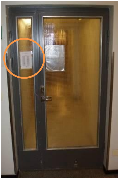
KUVA 34. S-osan 0. kerroksen ovi on vaikeakulkuinen, sekä siinä ei ole selkeästi havaittavaa opastetta tai tunnusta, joka kertoo sen takana olevasta invavessasta
