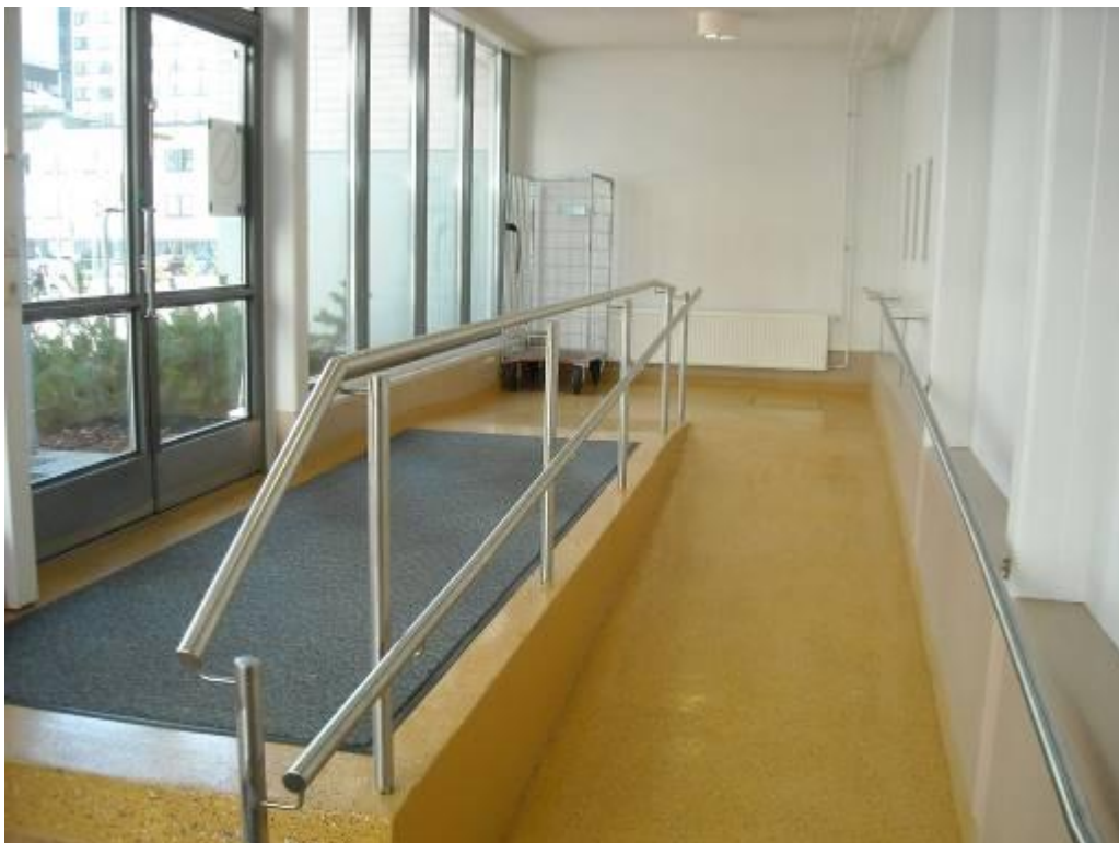
KUVA 12. Kuntokatu 4:n S-osaan johtava sisäänkäynti ja pyörätuoliluiska
