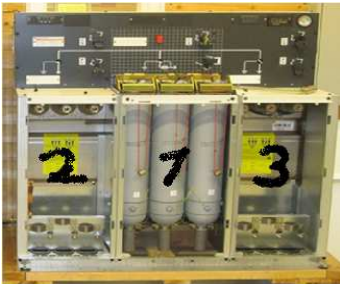
Kuva 28. Kennojen kaapelipaikat ja numerointi
