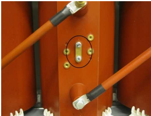
Kuva 30. Jännitteen säädön väliottokytkin
