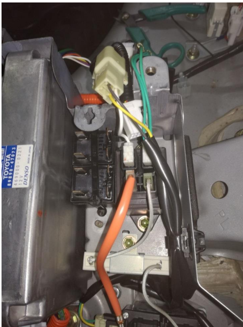
Kuva 10. kontaktorit kiinnitettynä akun kotelon sisälle
