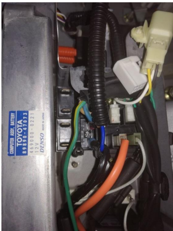
Kuva 12. Syöttöjohdot, ja alijännitereleelle menevä johto asennettuna
