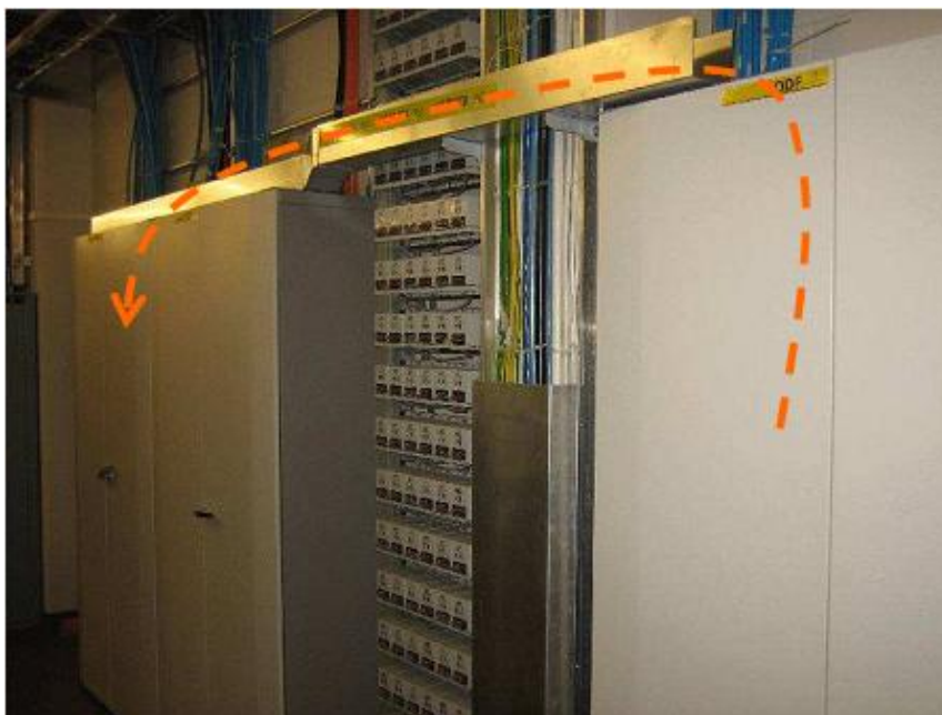
Kuva 15. Kuvaan piirretty kytkentäkuidun reitti.
