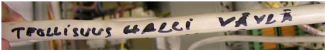
KUVA 22. Oikealla tavalla merkitty väyläkaapeli
