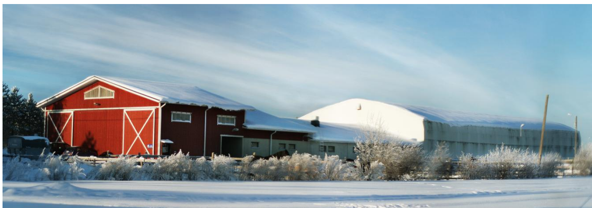
Kuva 18. Manunkylän Ratsutallin julkisivu
