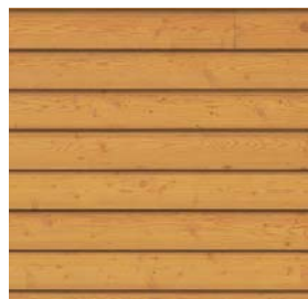
K1 katon sisäverhous, kuusipaneeli vaaka, profiili valeponttinen kääntö- paneeli leveä, öljytty Tikkurila Nostalgia Puuöljy luonnonvärinen
