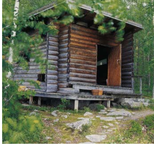
Kuva 26 Alvar Aallon Muuratsalon koetalon pihasauna soveltaa hirsirakennusperinnettä modernisti
