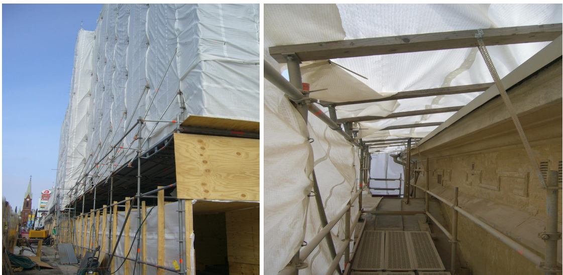
KUVA 17. Hallituskadun puoleinen julkisivusuojaus.
