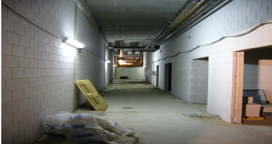
KUVA 3. Työmaan yleisvalaistus on riittävä ja alakeskukset kaapeleineen on nostettu seinälle.
