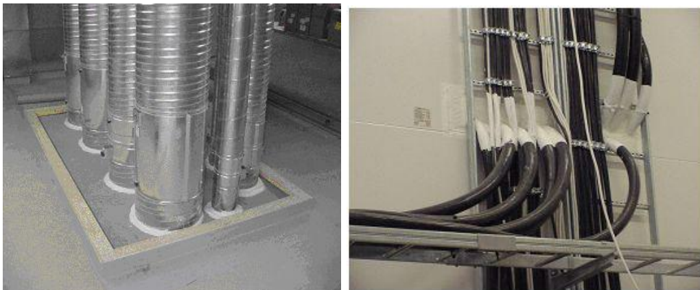
KUVA 8. Esimerkkejä läpivientien toteutuksista (Rögård 2007).
