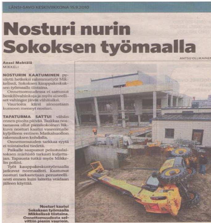
KUVA 18. Kurottajan kaatuminen esimerkkityömaalla (Länsi-Savo 15.9.2010).
