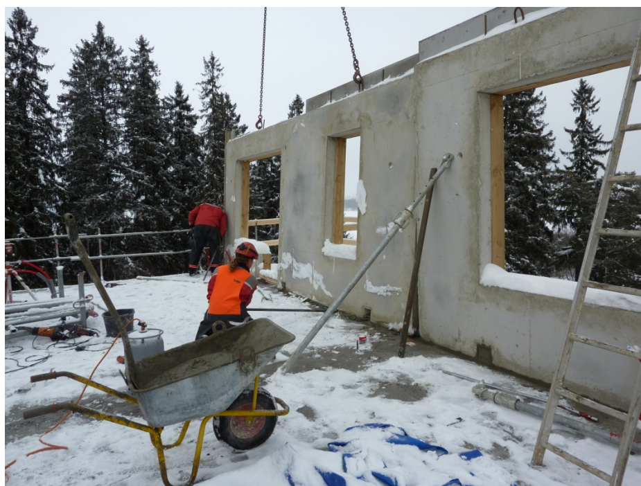
Kuvio 4: Elementtiasennus käynnissä
