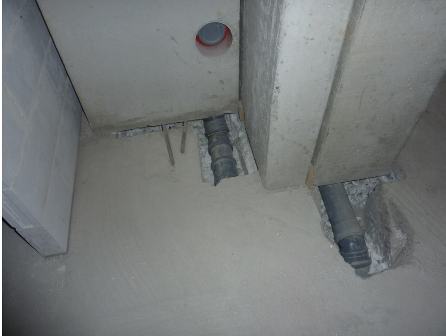
Kuvio 5: Hormielementille on jouduttu tekemään väliaikainen kannatus
