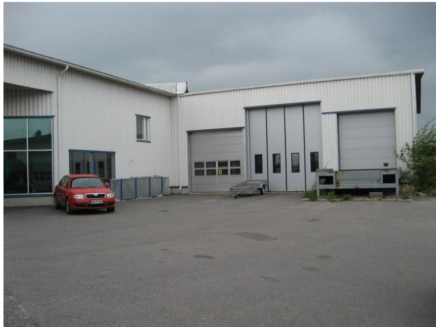
Kuva 13. Varaosavaraston laajennuksen sijainti.
