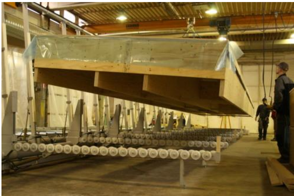
Kuva 3. Puuelementin asettelu kääntöaisalle.
