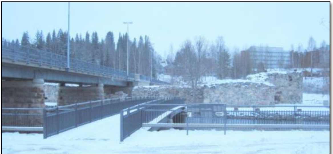
Kuva 17. Kajaanin linnanrauniot ja niiden yli kulkeva maantiesilta keskustan puolelta kuvattuna vuoden 2010 marraskuussa. Linnanraunioille menee kävelysilta ja sillan vieressä on opastetaulu.
