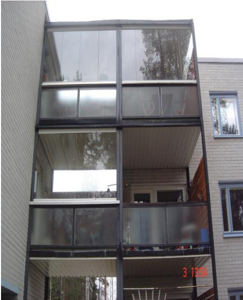
Kuva 1 Rakennuksia yhdistävä parvekerakenne
