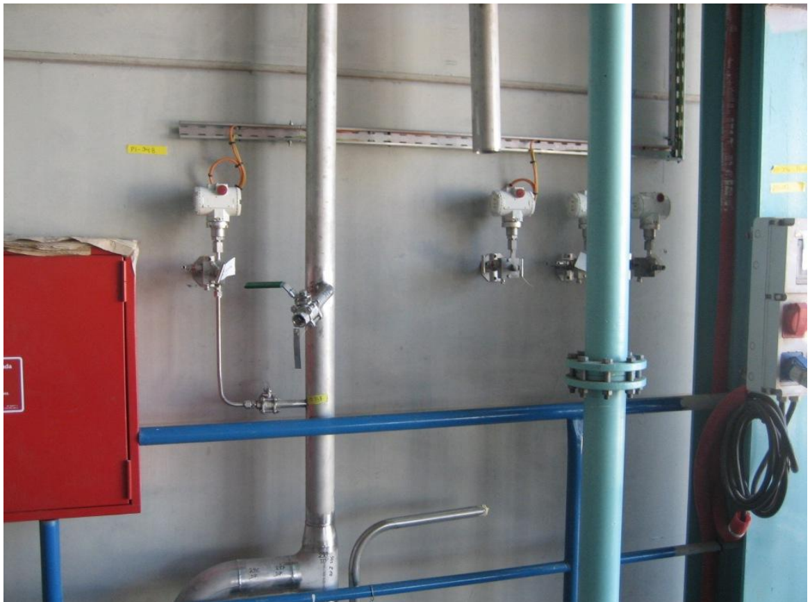
Kuva 15. Onnistunut yhteen sijoitus, jolloin yhde on sopivalla korkeudella tasoon nähden. Valokuva Janne Immonen.
