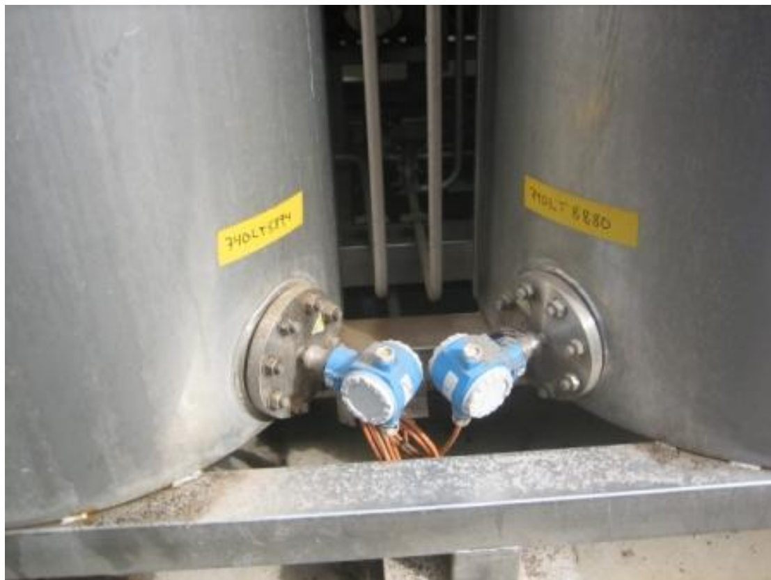
Kuva 10. Säiliön pinnankorkeuslähetin. Epäonnistunut yhteen sijoitus. Valokuva Janne Immonen.
