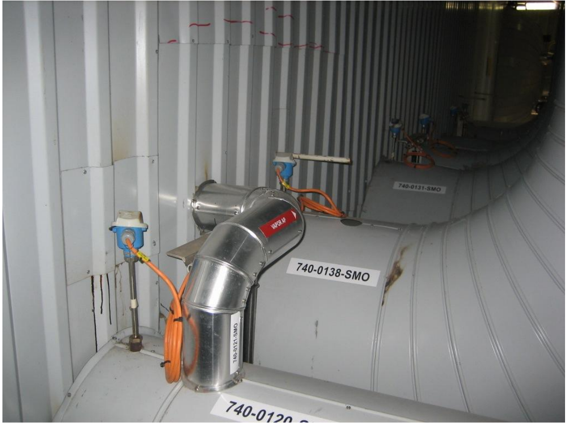
Kuva 13. Lähettimet liian lähellä seinämää. Epäonnistunut yhteiden sijoitus. Valokuva Janne Immonen.
