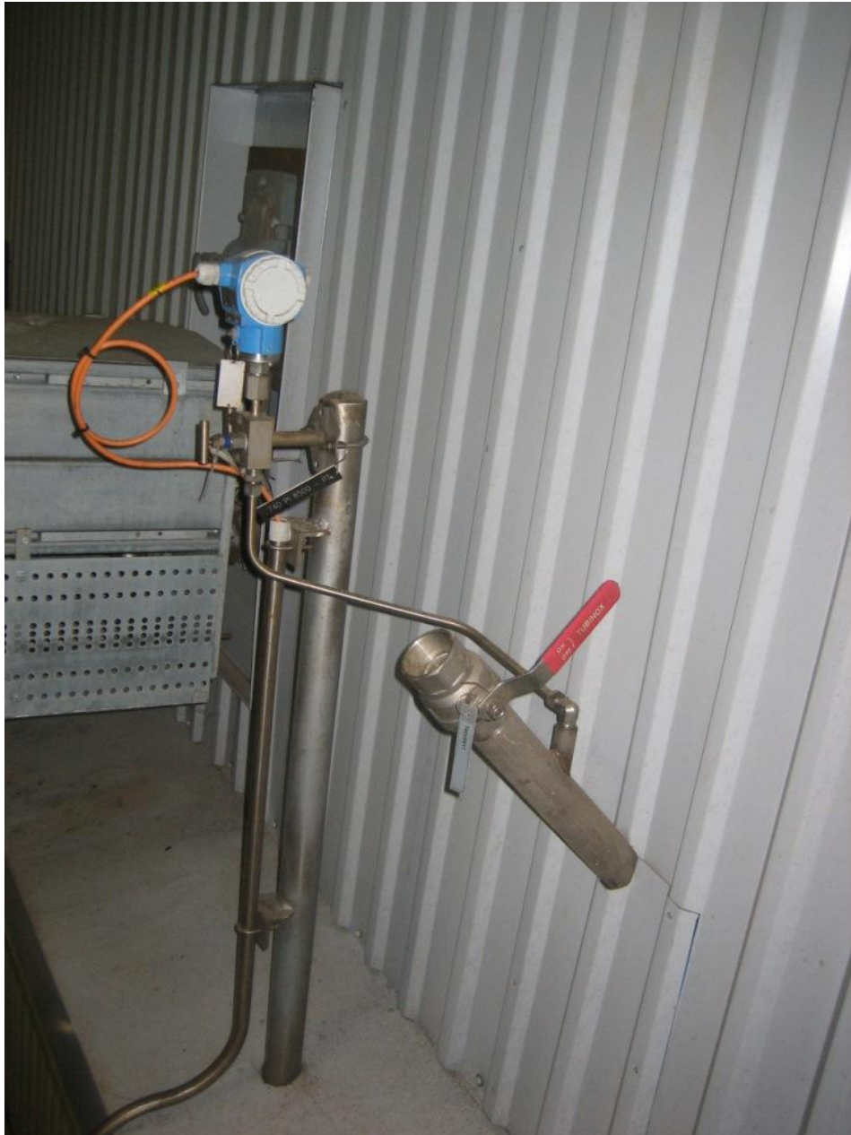
Kuva 14. Kattilan painemittaus nuohoimen luona. Onnistunut yhteiden sijoitus. Valokuva Janne Immonen.
