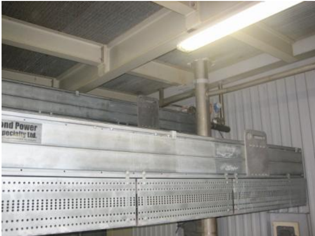
Kuva 12. Kattilan painemittaus nuohoimen luona. Epäonnistunut yhteen sijoitus. Valokuva Janne Immonen.
