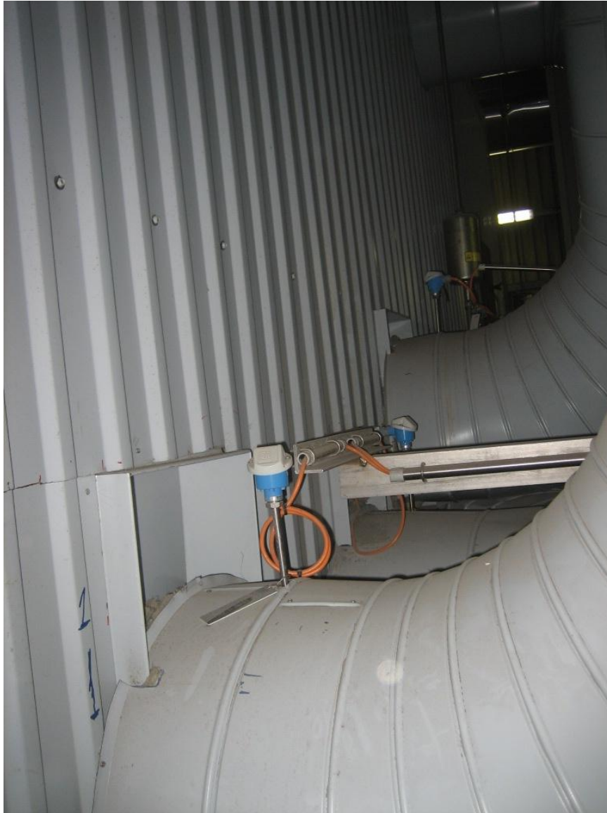
Kuva 16. Onnistunut yhteen sijoittaminen jättää riittävän tilan lähettimen ja seinämän väliin. Valokuva Janne Immonen.
