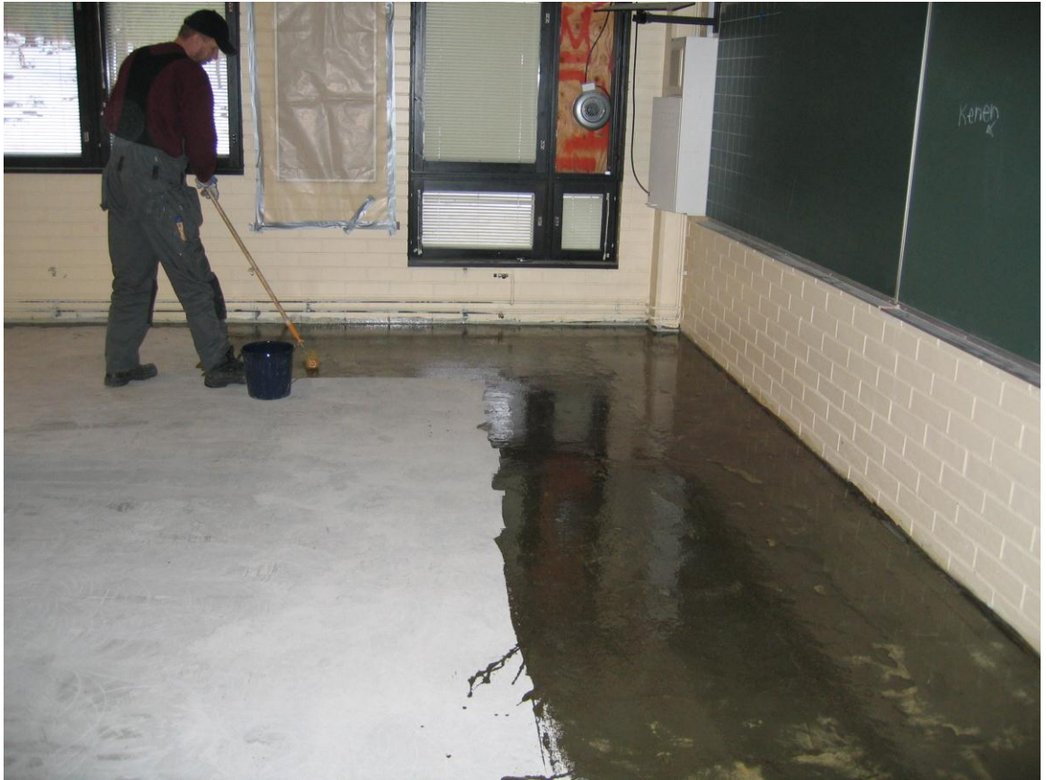
Kuva 6. Epoksipohjusteen levitys kuva Markku Miettinen
