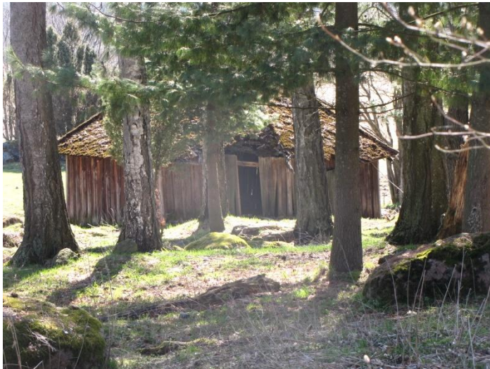
Kuva 20: Vanhassa pumppukopissa pumpattiin vettä härkävetoisesti vielä 1900-luvun alupuolella. Etualalla makedonian mänty.
