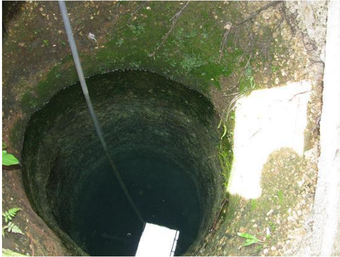
KUVA 4. Kaivo 15, Kamla. (Benito De Ávila ym. 2010.)
