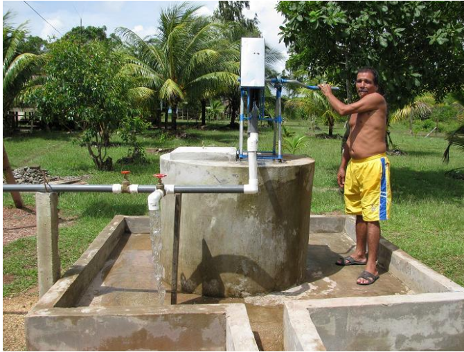
KUVA 6 . Umpinainen kaivo. Kaivo 20, Kamla. (Benito De Ávila ym. 2010.)
