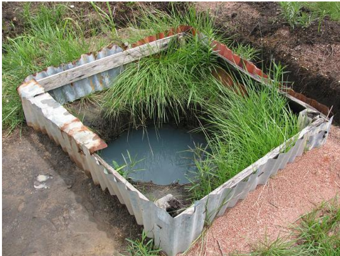
KUVA 5. Avonainen kaivo. Kaivo 7, Puerto Cabezas. (Benito De Ávila ym. 2010.)
