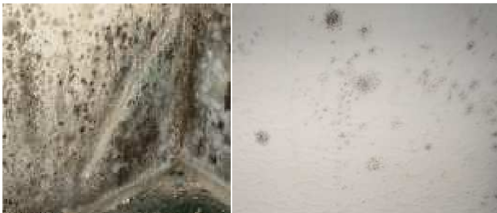
Figur 17: Svartmögel ser ut som svarta fläckar. Bilden till vänster visar ett allvarigare angrepp medan angreppet på bilden till höger inte ännu har hunnit bli så allvarligt (Mögelsanering).
