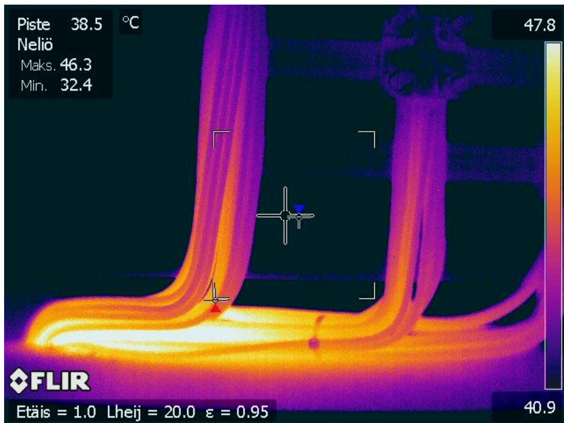
Kuva 10. Lämpimiä johtimia. (PK3 Valaistuskeskus, 150-7I3)
