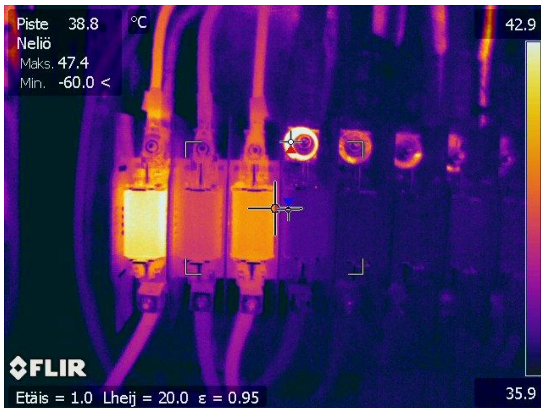
Kuva 7. Kahvasulakkeiden lämpötiläero. (PK2, 400V Valaistuskeskus 150-4I12)
