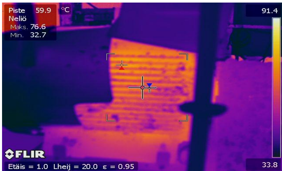
Kuva 12. Likainen moottori. (Viirapuristin 1, MC-pumppu 1, 41-6221)
