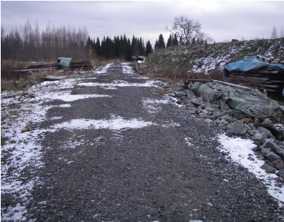
Kuva 12. Suojavalliin nähden liian korkealla kulkeva osa huoltotiestä. Oikealla suojavalli, jonka takana sijaitsevat kivääriradat.
