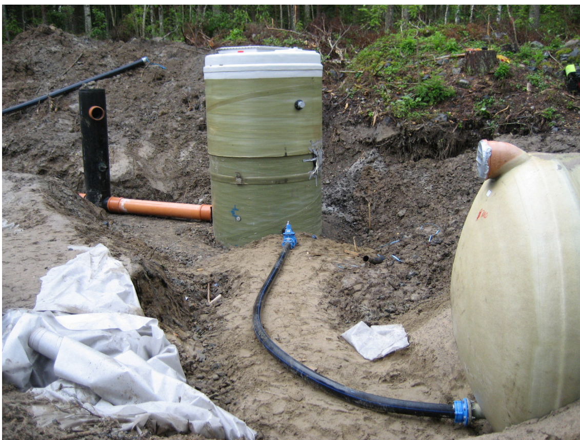
Kuva 2.3. Jätevesipumppaamon valmistuskokonaisuus. Kuva Pasi Hakkarainen
