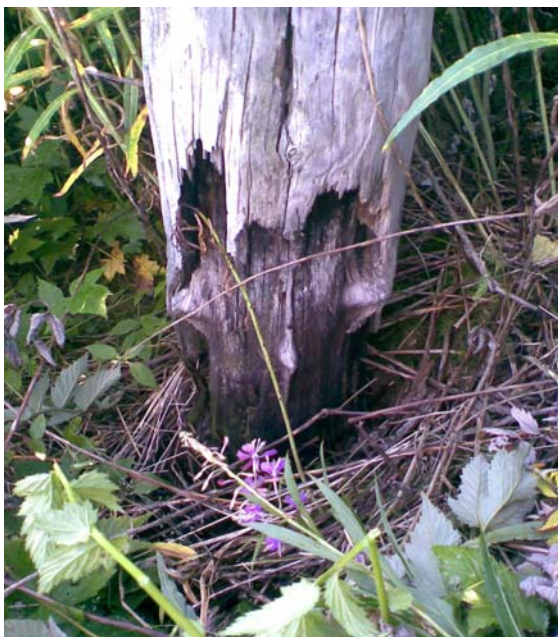
KUVA 2. Pahasti lahottajasienen runtelema pylvään tyvi. (Inspecta Oy)
