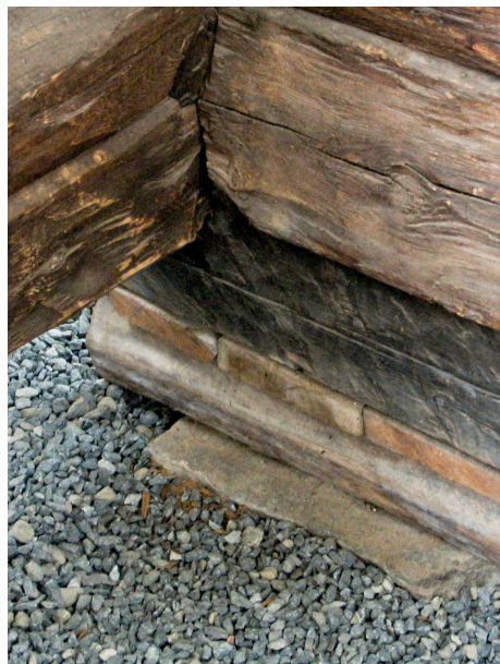
KUVIO 5. Saarnahuoneen suoraan kosketus maahan ja suojarakennuksen seinään
