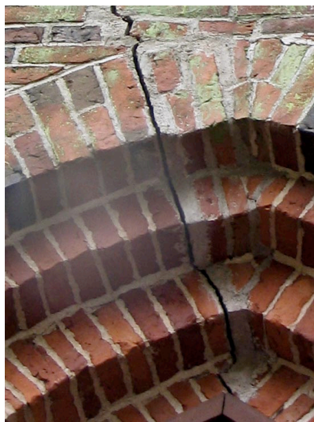
KUVIO 16. Halkeamia ulkoseinissä: ulko-oven yläpuolella ja seinässä ikkunan alapuolella.
