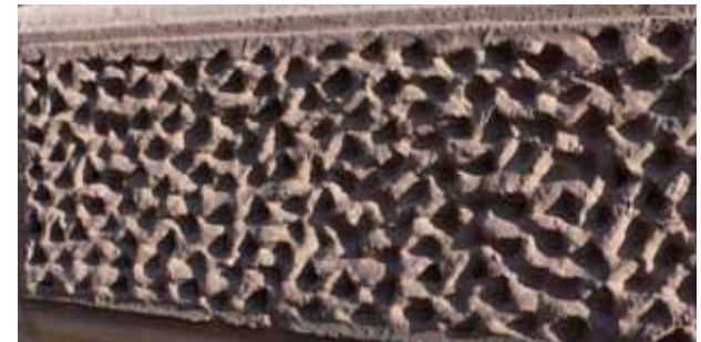
Yläriivin kuvat 27-32: Savilaasti pintakäsittelyä Decosin tuotteilla. Kuvat www.decos.fi Alempana, kuvissa 33-38, esimerkkejä kalkkirappauksesta, joita voisi soveltaa myös savirappaukseen. Kuvat Jukka Kinnunen, Helsingin julkisivurappaus Oy, www.julkisivu.com
